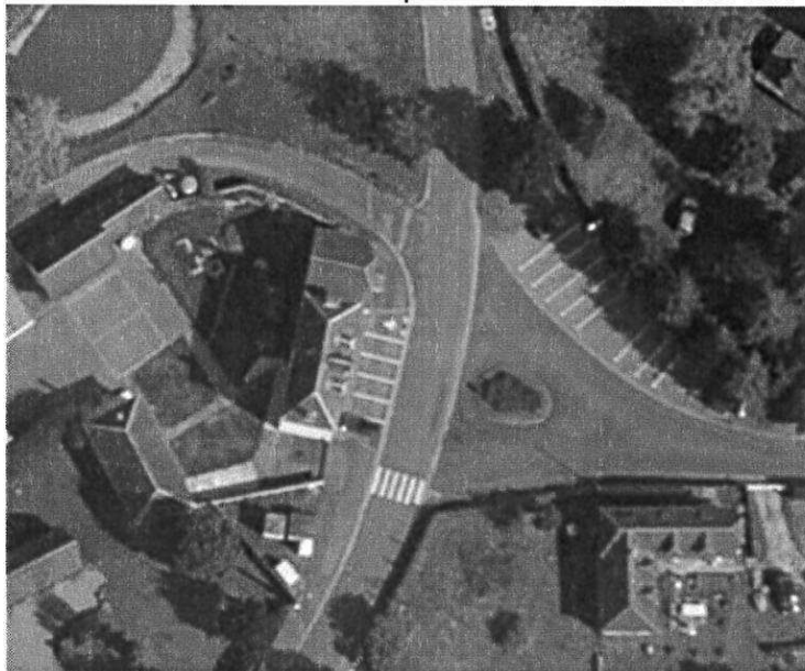
Place de la Mairie avec 14 places dont 1 réservée au PMR.
